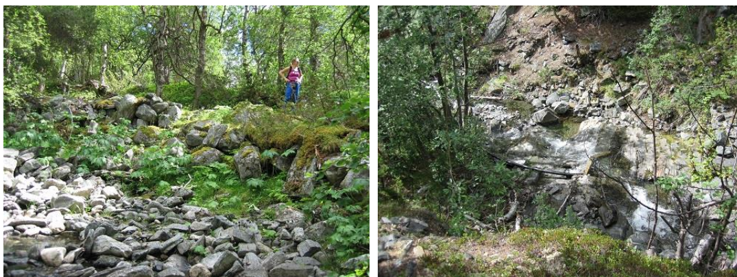
Figur 19: Bilder fra Fotfola 750-800 moh. Viser nærbilde av gammel erosjonssikring til venstre. Høyre bilde viser vannuttak litt lenger nedstrøms.
