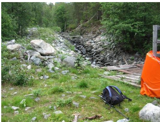
Figur 21: Bilder fra utløpet av sedimentasjonsdam i Fotfola til venstre ca. 750 moh. Helt til venstre mot trærne tok vannet en ny flomvei i 1938. Høyre bilde er tatt fra skibrua (ca. 720 moh) og oppover, der flomveien gikk til venstre i bildet bak sikringsvollen.
