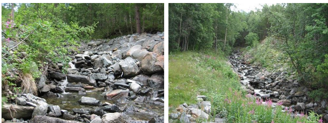
Figur 26: Til venstre er nærbilde (sett nedenifra) av sikringstiltaket i det midterste området hvor vannet tok på avveie mot høyre i 1938. En ser at det er brukt spesielt stor stein i denne sikringen. Det høyre bildet er tatt litt lenger nedenifra.
