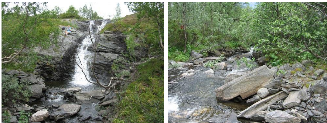
Figur 12: Bilder fra Fotfola rett nedstrøms parkeringsplassen på Fjellvegen. Viser bl.a. mye tilgjengelige løsmasser med til dels store steiner/blokker, samt mye tett vegetasjon nedover. Helt til venstre sees litt av gammel forbygning (steinmur).
