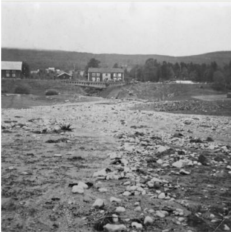
Figur 6: Viser utvasket jernbanefylling og store sedimentmengder på jordet rett nedstrøms Knipstugu etter ekstremhendelsen i 1938.
