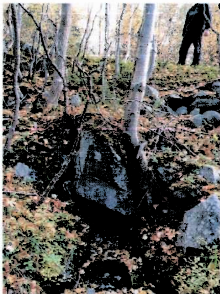
Figur 14: Bilder av sammenrast stikkrenne under skogsbilvei ca 775 moh. Dette er et sårbart punkt som bør ordnes relativt snart.
