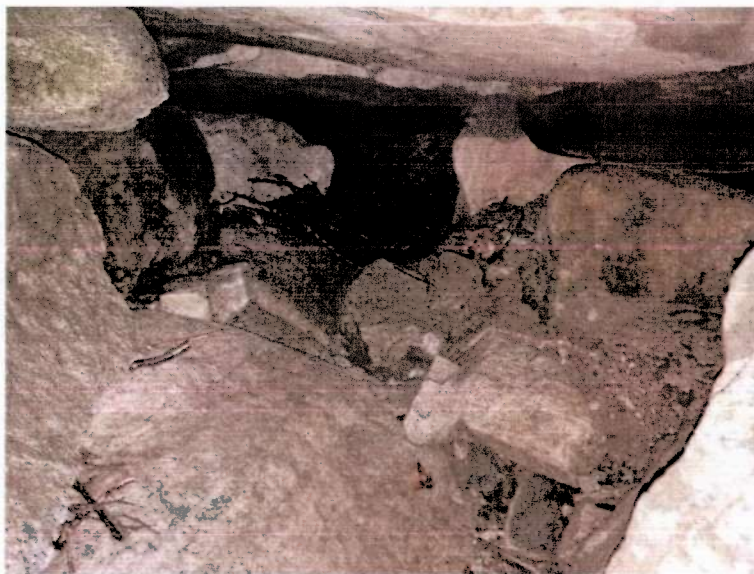
Figur 14: Bilder av sammenrast stikkrenne under skogsbilvei ca 775 moh. Dette er et sårbart punkt som bør ordnes relativt snart.
