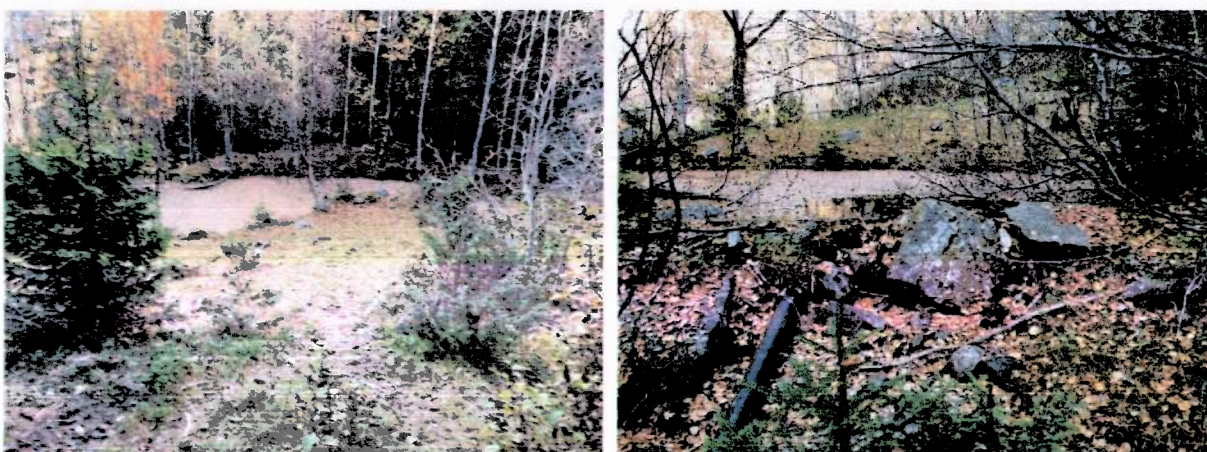
Figur 19: Bilder av vanningsdam litt lavere enn 700 moh, sett ovenfra til venstre og nedenfra til høyre. Den er planlagt å bli rehabilitert. Øverste delen av jordet sees i venstre bildes kant i venstre bilde. Dette er nå et sårbart område med fare for vann mot jordet og må tas hensyn til ved rehabilitering.
