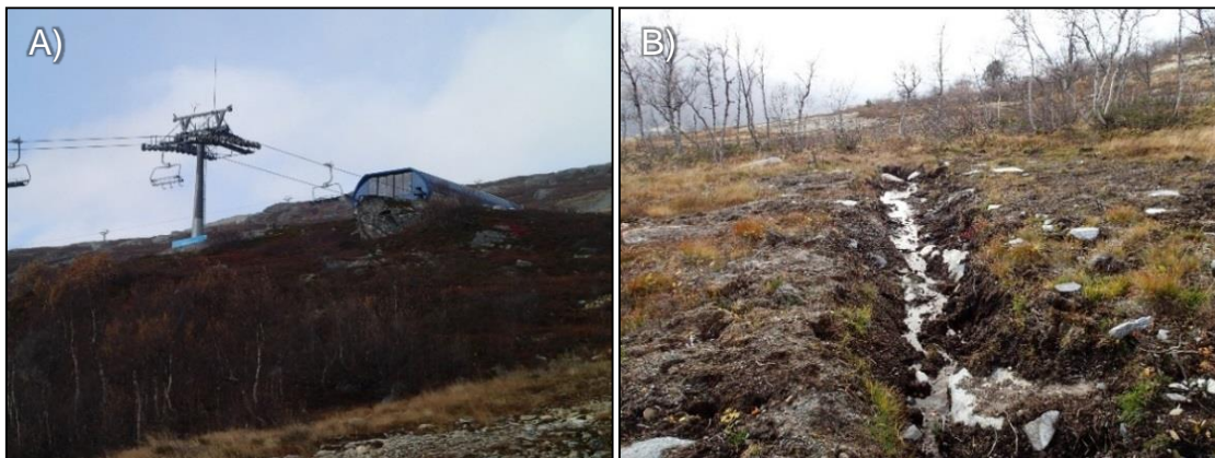
Figur 7: A) Øvre del av skianlegget. B) Dreneringsrenner i jordmasser.
