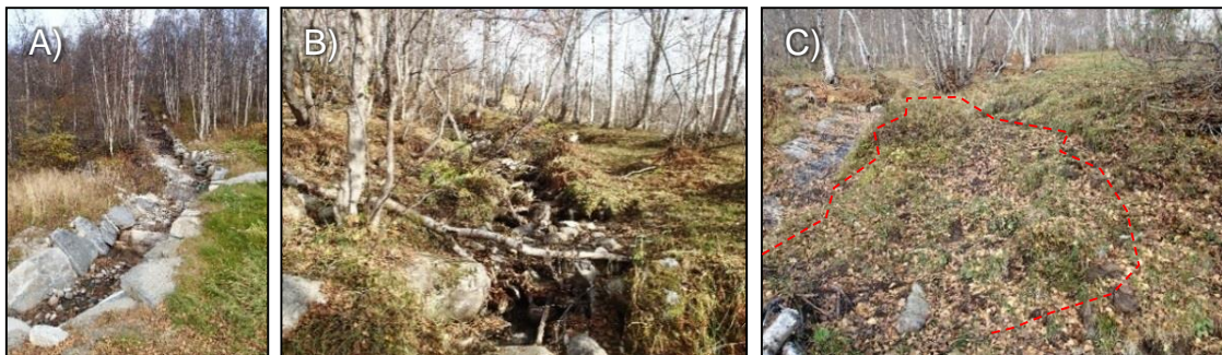
Figur 6: A) Bekkefar på vestsiden av skianlegget i nedre del. B) Terrenget på vestsida av skianlegget i nedre del. C) Mindre grop etter utglidning av masser.
