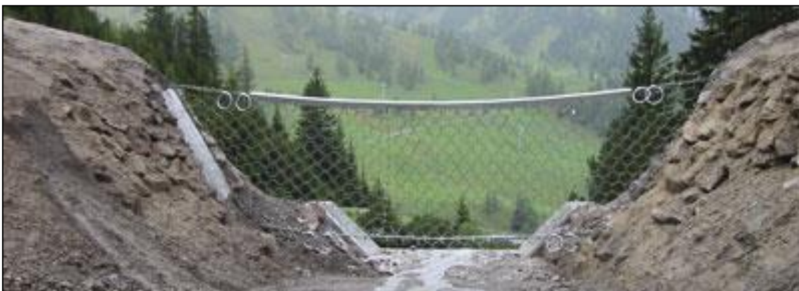
Figur 12: Eksempel på et fanggjerde fra Alpe ( www.geobruigg.com )
