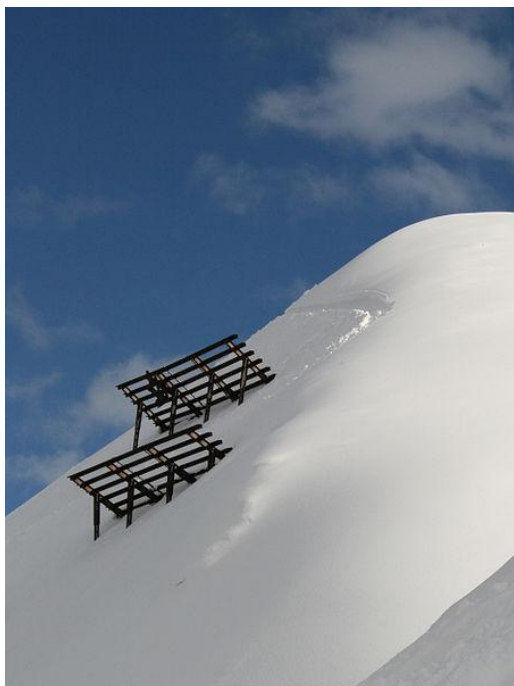
Figur 8: Støttekonstruksjon i løseområdet (på bildet er de lagt av stål)
